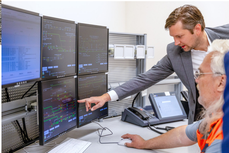
Unten: Inbetriebnahme des neuen Elektronischen Stellwerks München Ost im Juni 2025. Foto: Deutsche Bahn/Thomas Kiewning
