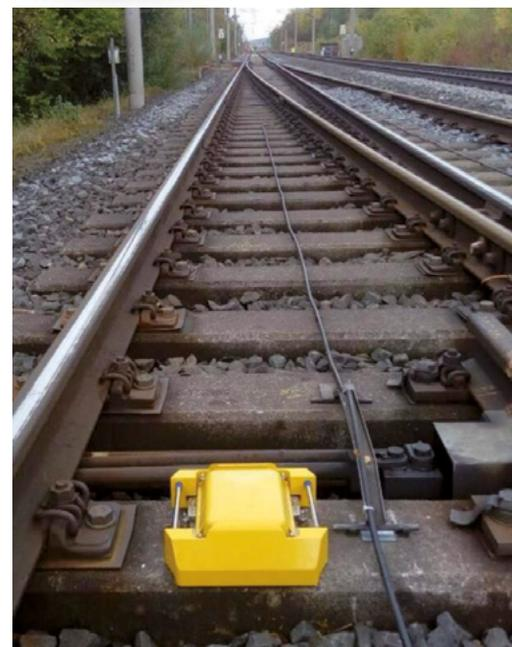
Datenbasierte Weichenüberwachung mit der IIoT-Analyseeinheit von Konux (siehe linkes Bild) hilft Verspätungen im Bahnverkehr zu reduzieren.
